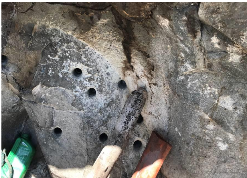
Figura 10 - Furos realizados para abertura de nova frente de lavra (ambiente a céu aberto)
