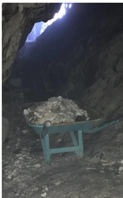
Figura 13 - Carrinho de mão já carregado na frente de lavra
